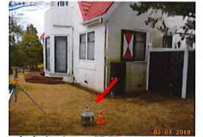
定点カメラの設置
