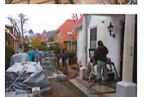
注入状況モニター管理
