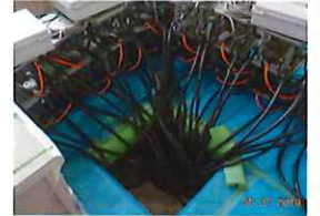
床下収納庫より配管の設置
