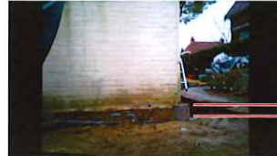
外部定点カメラ画像① 北側門扉横 施工前
